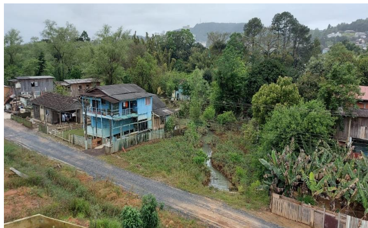
Figura 4. Construção precária em área de risco no Bairro Pamplona.
