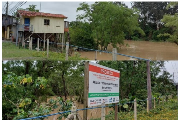
Figura 3. Construção precária em área de risco no Bairro Pamplona.
