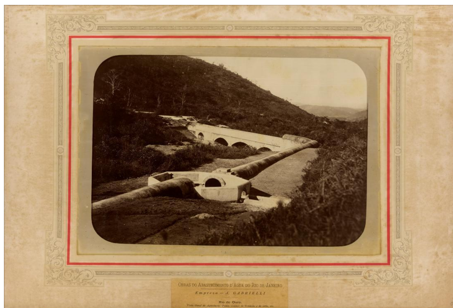
Figura 1 – Marc Ferrez. Obras de abastecimiento de agua de Río de Janeiro: Río do Ouro: vista general del acueducto, puente, cajas de reunión de aire, etc., 1876-1882. Río de Janeiro, RJ / Archivos FBN
