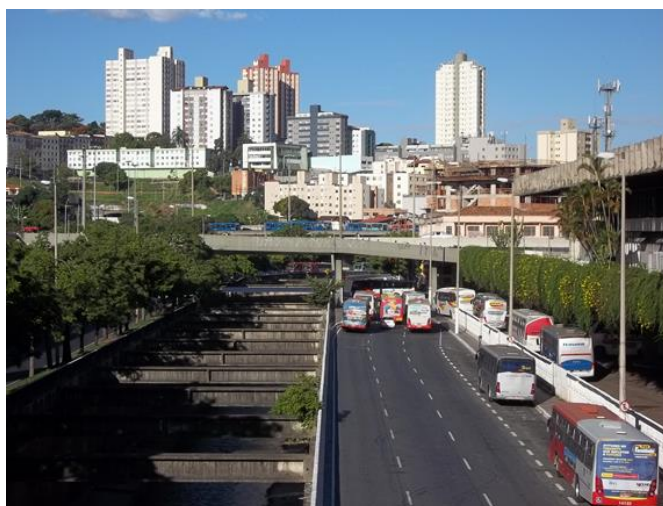
Figura 3 – Vista do Complexo Viário da Lagoinha e Rio Arrudas
