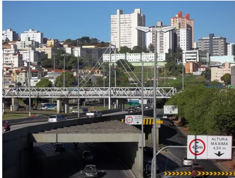
Figura 4 - Vista do Complexo Viário da Lagoinha e passarelas
