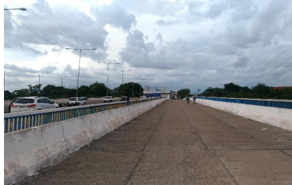
Figura 05 – Ampliação construída para o V.L.T.
