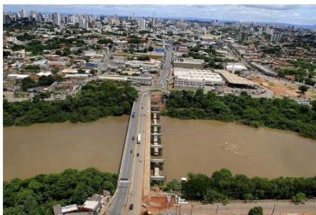
Figura 2 - A ponte em sua última transformação
