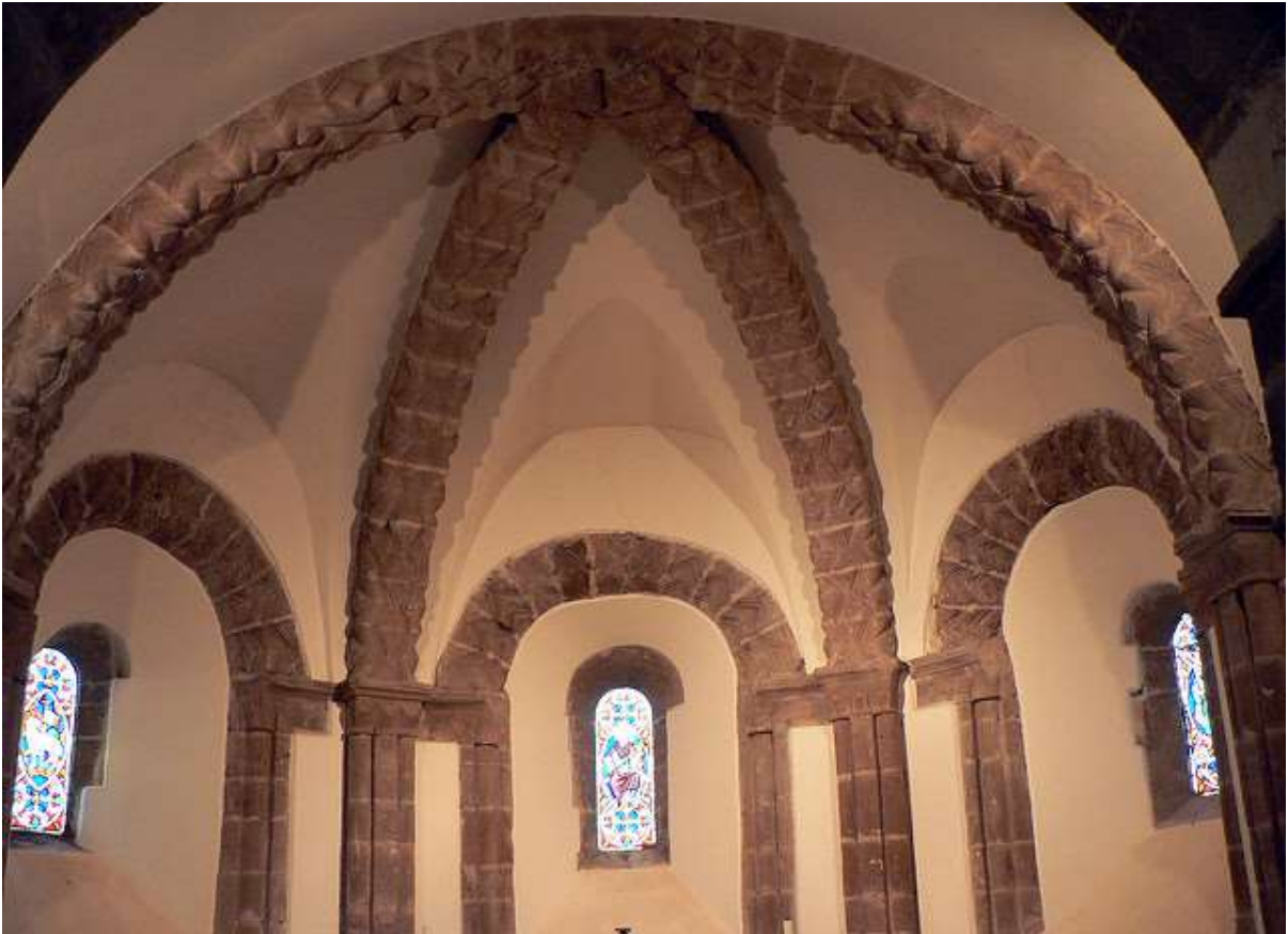
Imagem 7: Detalhe das nervuras da abside. Fonte: https://www.flickr.com/photos/trelewis/ , acessado pela última vez em 14 de março de 2016.
