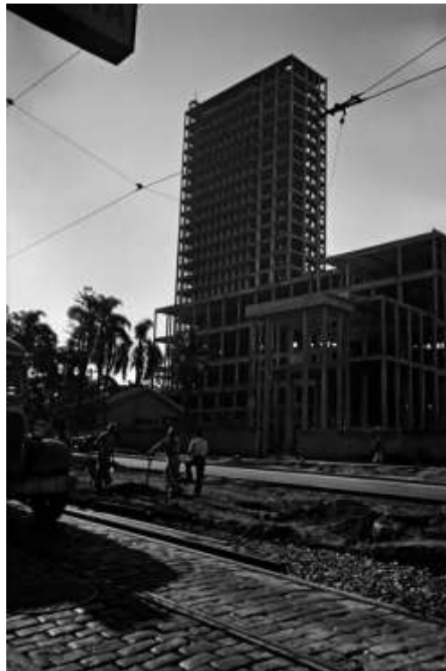
Imagem 4: Biblioteca Municipal em construção, na rua da Consolação, São Paulo, SP, 1940. Fotógrafa: Hildegard Rosenthal.
