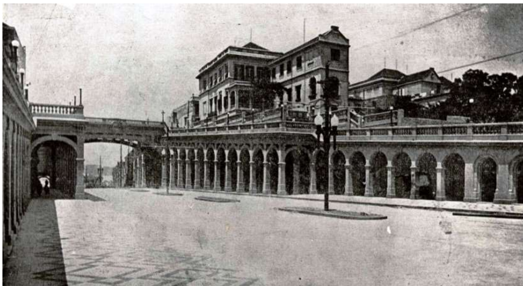
Figura 006 – Viaduto Otávio Rocha
