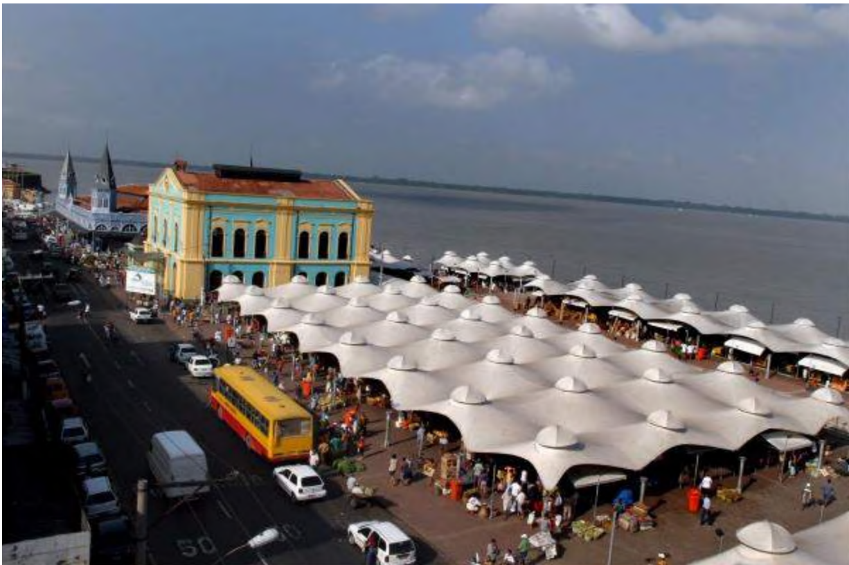
Figura 1: O Mercado de Peixe, o Solar da Beira e a área das barracas. Fonte: As Falas da Pólis (2016).
