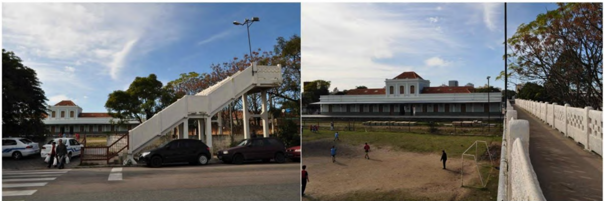
Figura 2 Viaduto. Foto: Mauro Bruschi, 2015.
