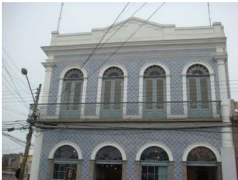
Figura 06: Sobrado Dos Azulejos Após Reforma (Autoria Própria Tirada Em 30 De Agosto De 2010)
