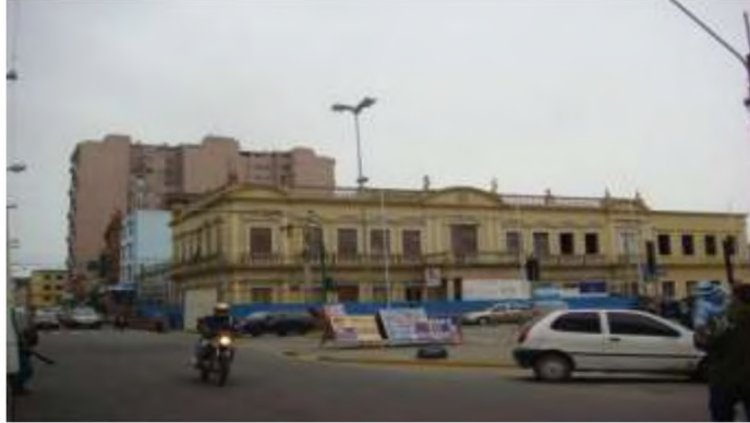
Figura 07: Prefeitura Municipal Do Rio Grande Em Processo De Reforma (Autoria Própria Tirada Em 30 De Agosto De 2010)
