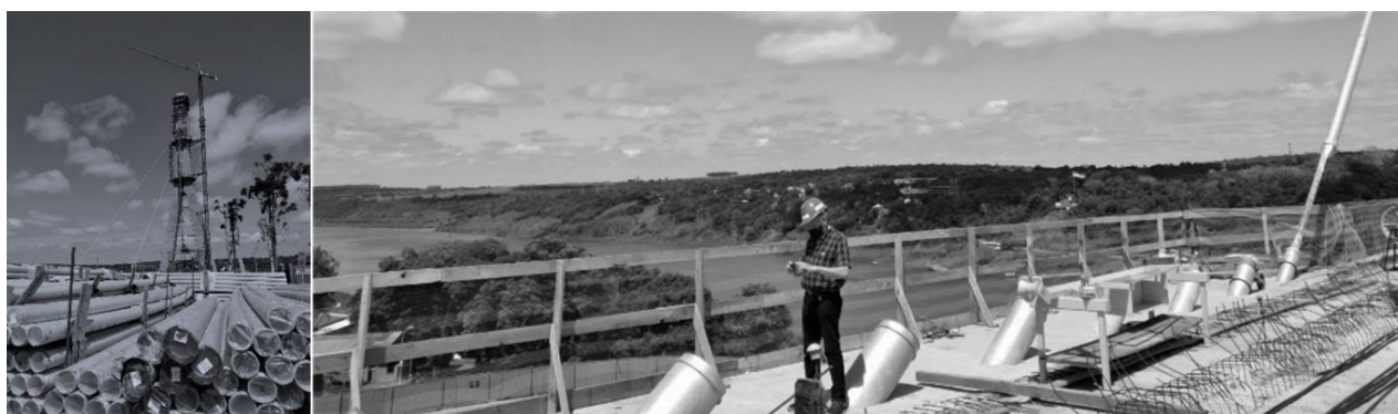
Figura 6 – Obras da Ponte da Integração entre Brasil e Paraguai (2021)
