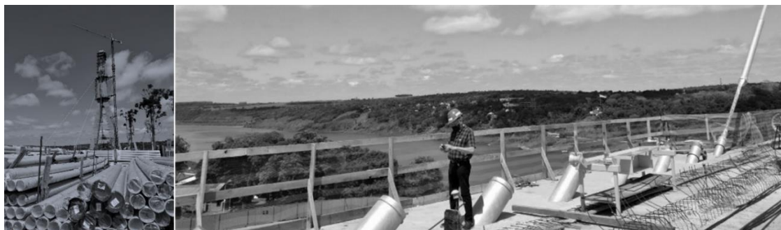
Figura 6 – Obras del Puente de la Integración entre Brasil y Paraguay (2021)
