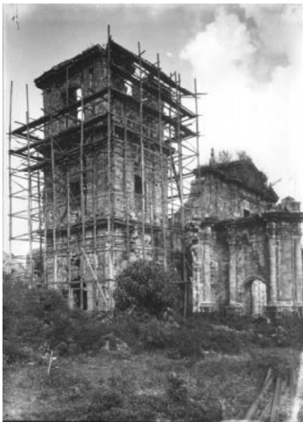
Trabalhos de estabilização da Torre Fonte: Noronha Santos, 1925. 108
