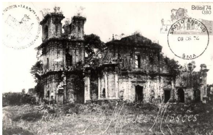
Igreja de São Miguel das Missões antes das intervenções do governo do Estado. Sem data. Fonte: Arquivo Escritório Técnico Missões – IPHAN
